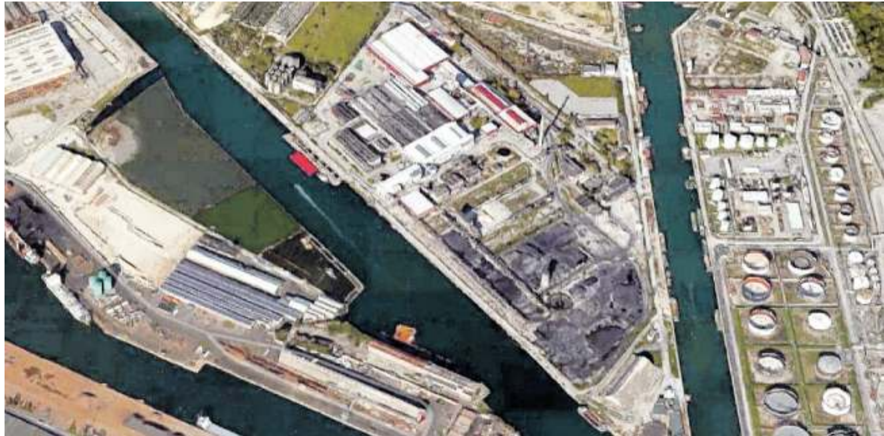
L'AREA I canali industriali di Porto Marghera dove dovrà sorgere il nuovo porto per le crociere con navi di grandissima stazza. La sfida ora è anche quella di pensare a come trasportare migliaia di passeggeri
